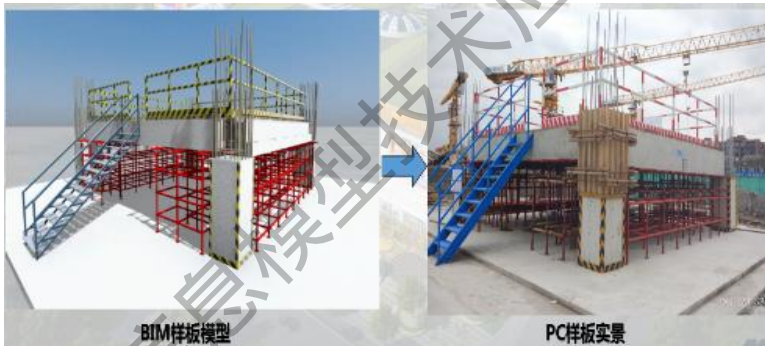
图 2-51 BIM 样板模型及实景
