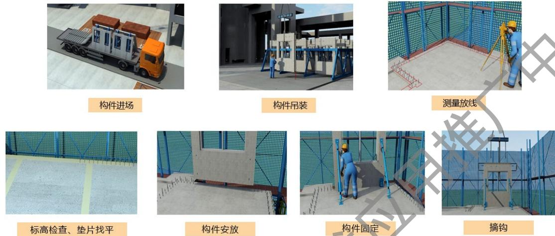
图 3-12 装配式施工方案模拟
