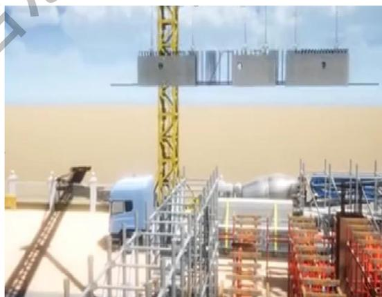
图 3-16 PC 构件吊装模拟
