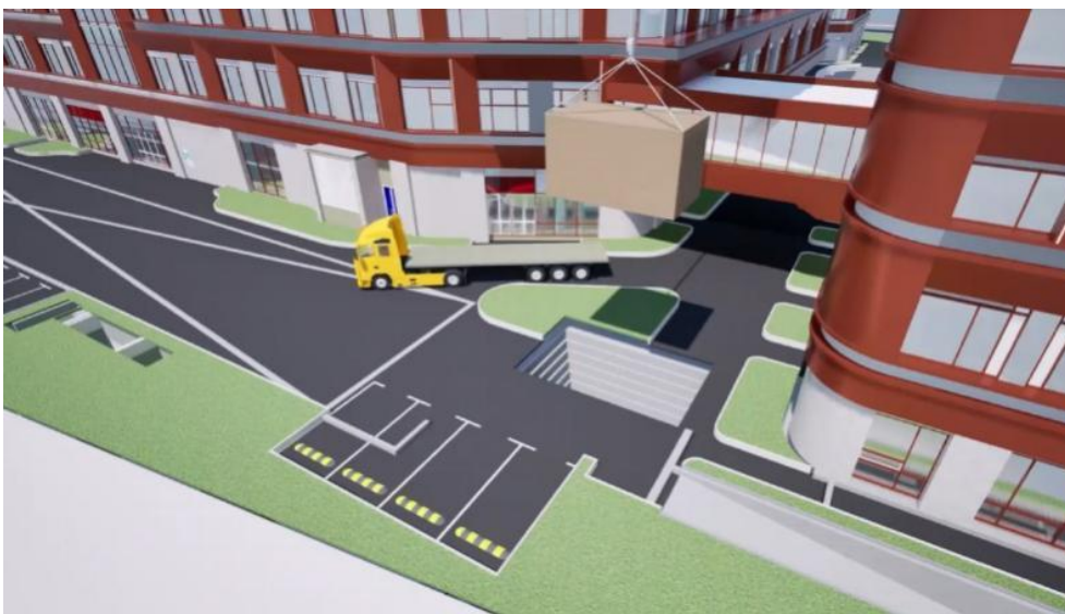
图 3-14 质子加速器吊装路径模拟
