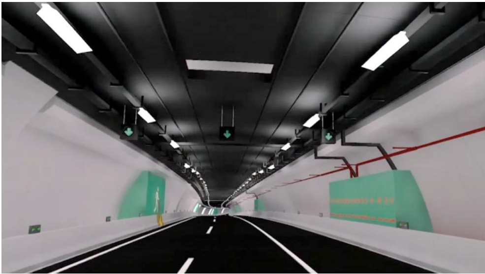
图 3-7 隧道内部漫游
