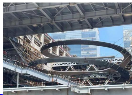
图 3-4 旋转坡道施工
