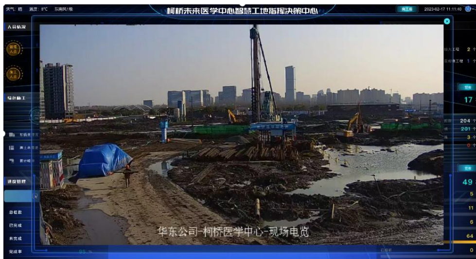
图 3-36 BIM 智慧工地平台—可视化对讲
