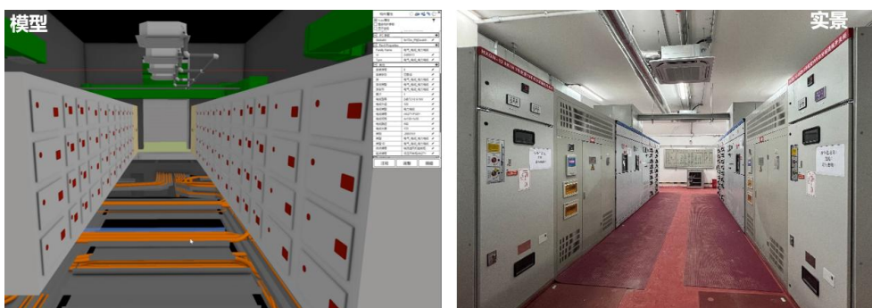
图 3-14 设备竣工模型与实景对比
