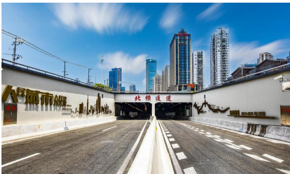
图 1-1 北横通道东段工程实景图
