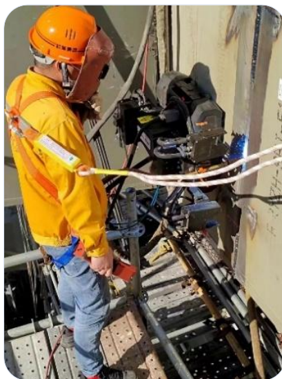
图 3-14 无轨道全位置爬行焊接机器人
