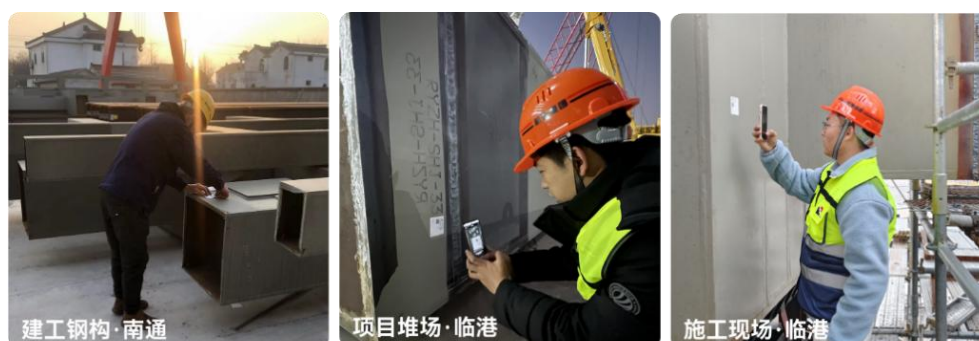
图 3-9 基于平台移动端扫描采集施工时间数据
