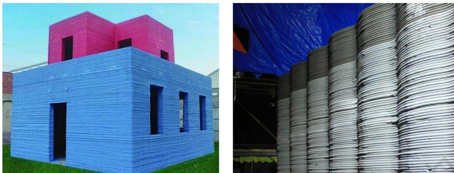
图 3-95 可居住、可交付使用的现场 3D 打印两层建筑
